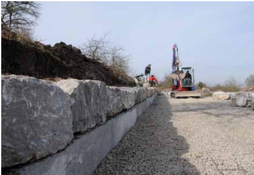
In Oeffingen wurden zwei Beachplätze von Grund auf neu erbaut. Hierfür wurde zunächst über die gesamte Fläche ein halber Meter Erde abgetragen und eine Drainage gelegt. Die Anlage verfügt über eine Tribüne aus Natursteinen.
