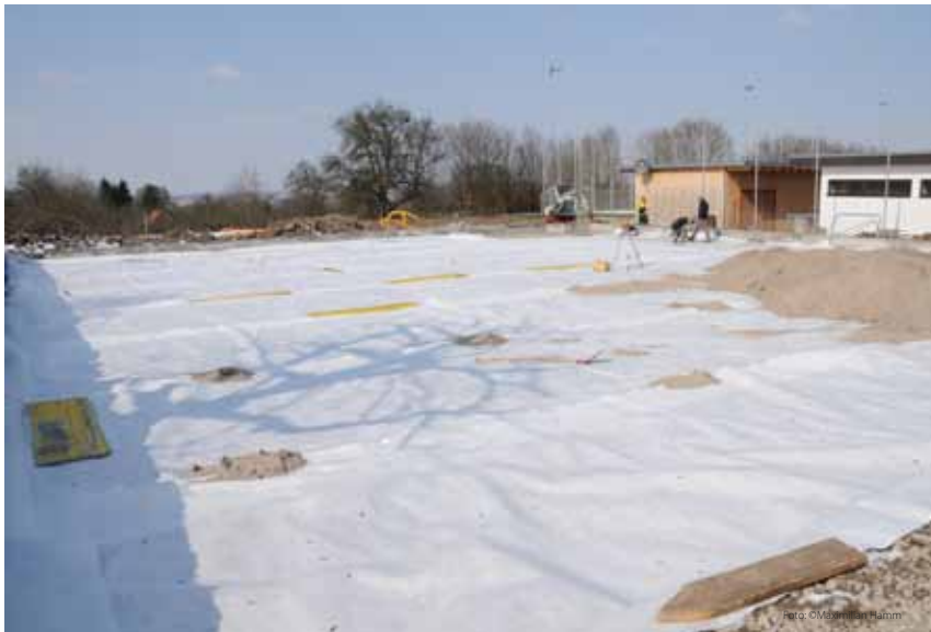
Die Anlage in Oeffingen erstreckt sich über eine Größe von 24 x 28 Metern. Für etwa 15.000 Euro wurde um das Gelände herum ein Metallzaun errichtet. Bei Fragen rund um den Bauprozess hilft der Beach-Tennis-Arbeitskreis des DTB.
